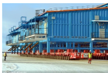
Рис. 10. Передвижка строений от пристани разгрузки до места стоянки
