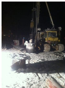
Рис. 6. Установка ТБЭ в проектное положение в ММП
