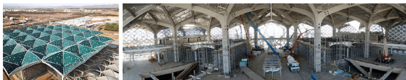
Рис. 2. Композитная крыша для высокоскоростной железнодорожной станции Аль-Харамейн
